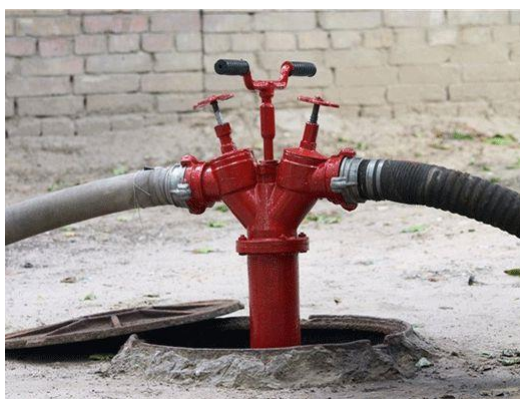
Рисунок 79. Пожарный гидрант.
